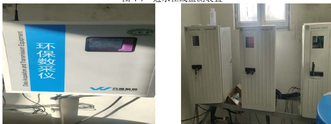
图 4-8 出水在线监测装置
