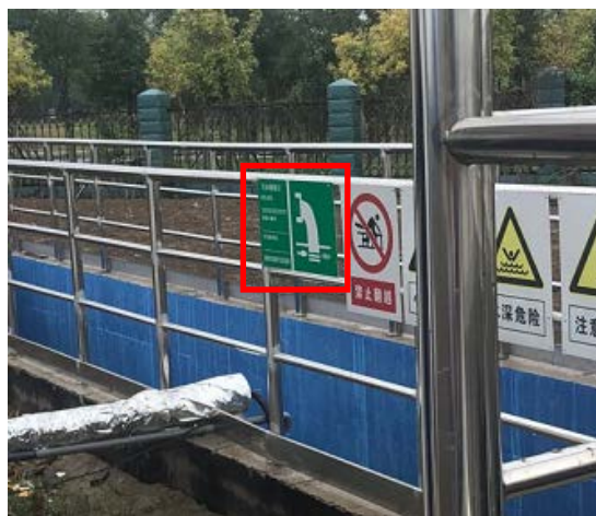
图 4-10 厂区废水总排口标志牌
