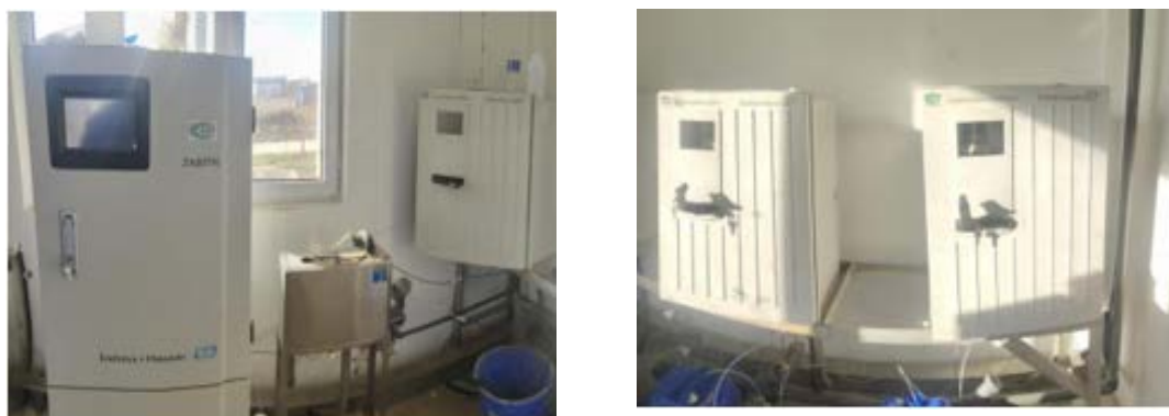
图 4-7 进水在线监测装置
